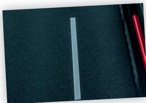
In de open structuur van ZOAB wordt veel van het slijtstof van autobanden opgenomen. Foto: Michiel Kole
