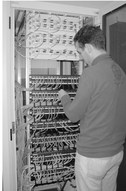
FIGUUR 3.1 Een patch panel
